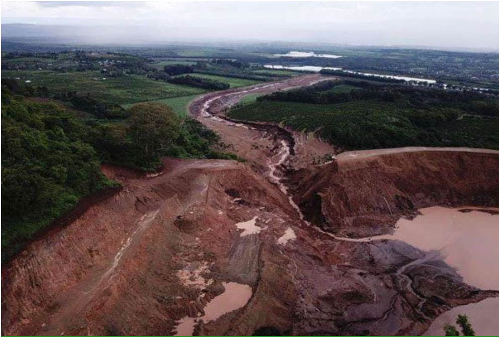
Bwawa la Patel Milmet, lililo jengwa kwa kingo za udongo, linamilkiwa na watu binafsi, eneo la Solai, Kaunti ya Nakuru, Bonde la Ufa, Kenya. Kufuatia mvua kubwa iliyonyesha, bwawa lilivunja kingo zake tarehe 9 Mei 2018, na kuua watu 48.
